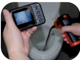
Fontanería For plumbers
