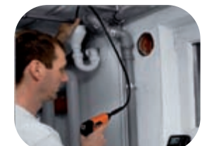
Inspección de tuberías Checking into pipe
